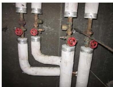
Vannes en pied de colonne montante
