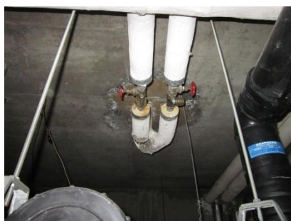
Vannes en pied de colonne montante
