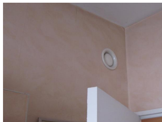
Grille d'extraction dans les pièces humides
