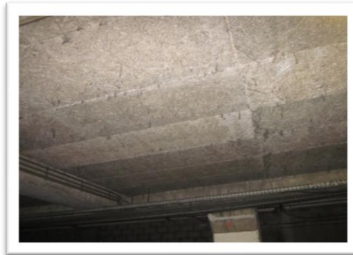
Photo 2 : Isolation des planchers bas donnant sur les sous-sols
